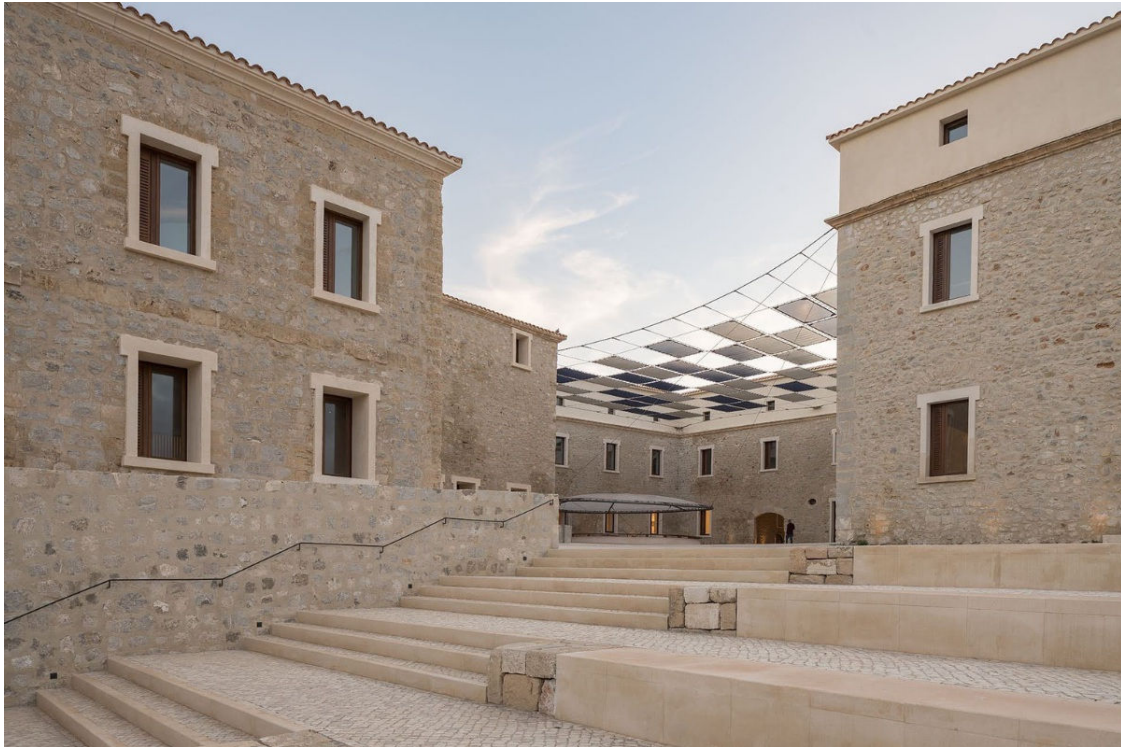
Parador de Ibiza. Imagen de los arquitectos Lliso & Manzano-Monís en X.
