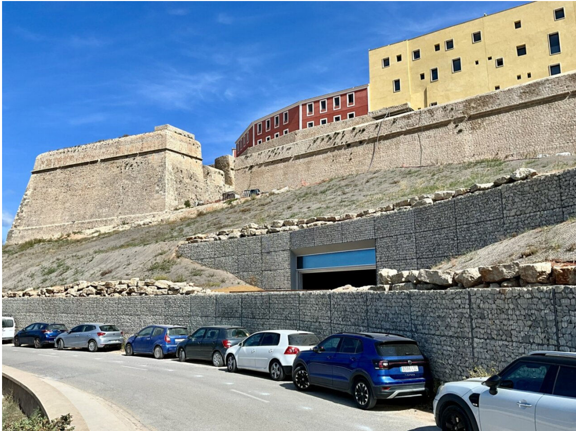
Recepción y aparcamiento del Parador de Ibiza. Lliso & Manzano Monís en X.
